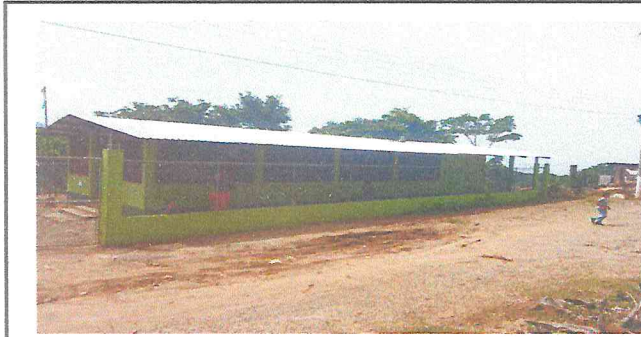
Foto1: Sustitución de lámina por lámina troquelada en los tres módulos de aula.
