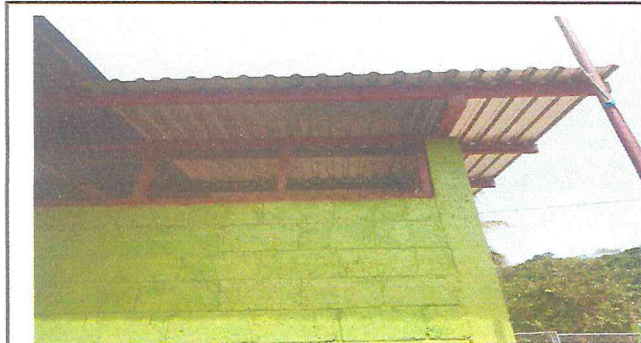
Foto 3: Se sustituyó estructura de soporte por estar en mal estado.
