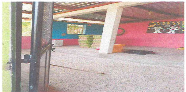
Foto 6: Sustitución de torta de piso por piso de granito en el módulo de aula.
