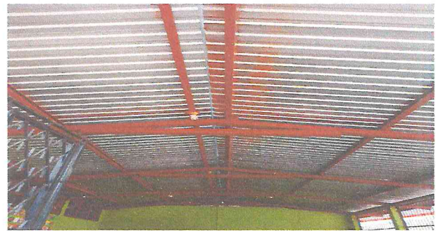
Foto 2: Mantenimiento a estructura metálica a todas las aulas.
