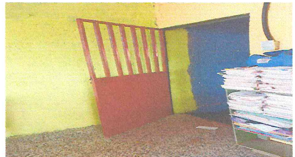
Foto 4: Sustitución de puerta de metal para poder ingresar al módulo de aula de preprimaria.
